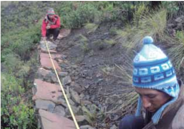
Foto 1: Comunarios realizando obras de construcción de terrazas.
