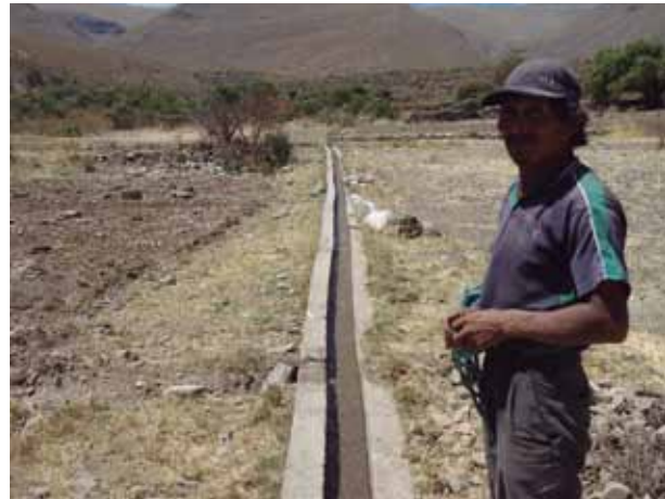
Foto 7: Construcción de canales de riego secundarios y terciarios.
