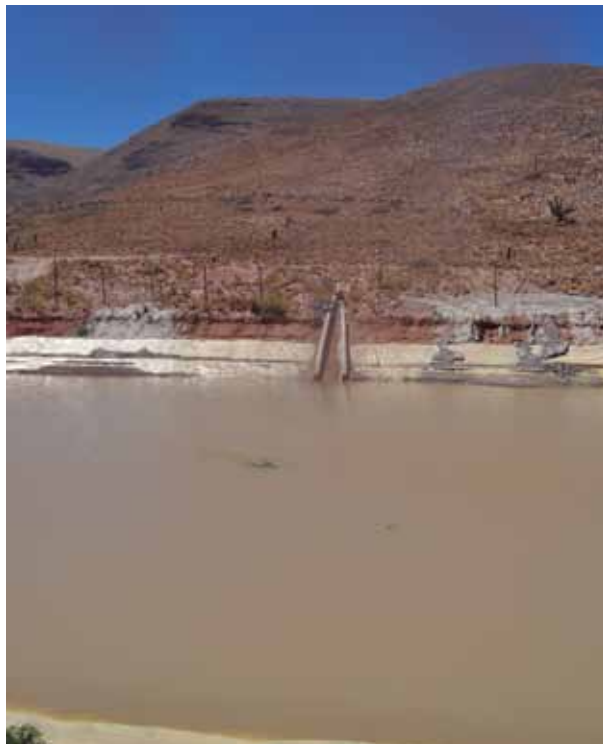
Foto 12: Mejoramiento de las obras de arte de un atajado en Yunchará.
