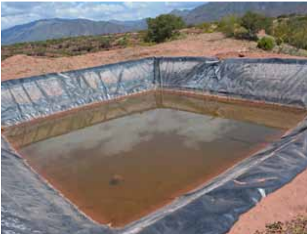
Foto 1: Obra realizada de manera concurrente con la finalidad de proveer de agua para la producción.
