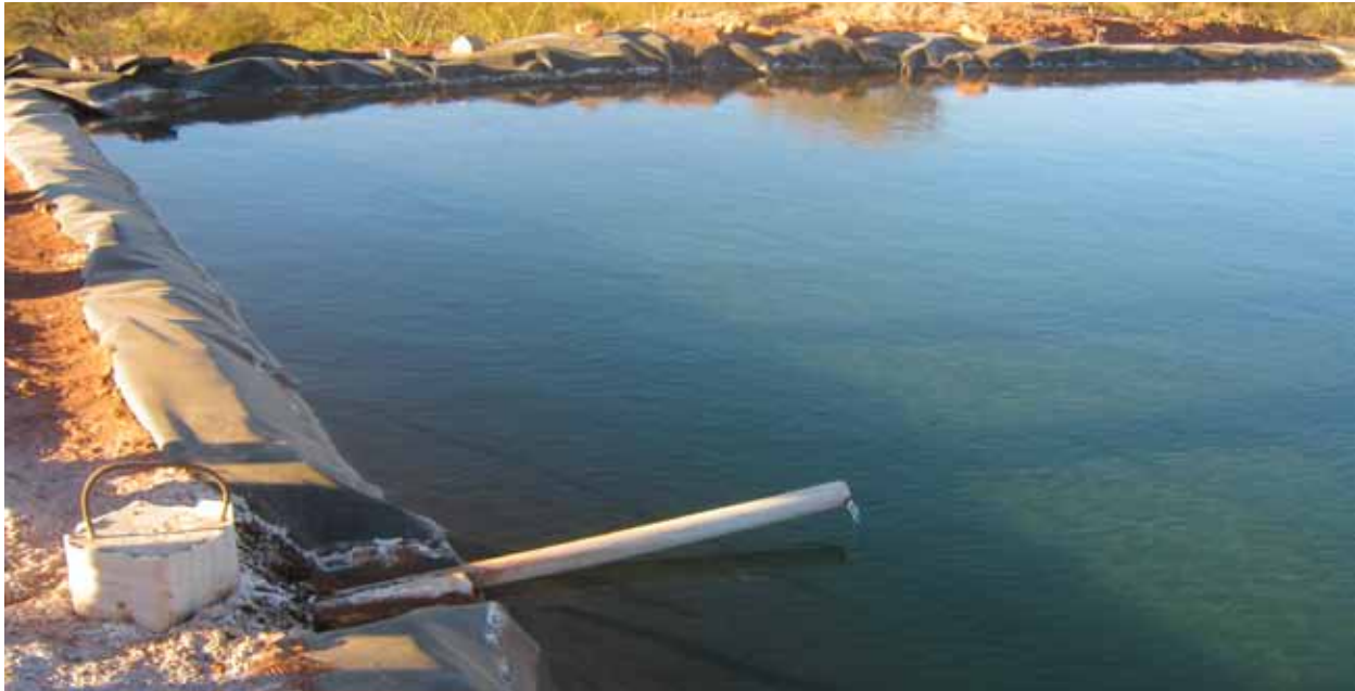
Foto 3: Obra construida para beneficiar a las familias productoras de Los Cintis.
