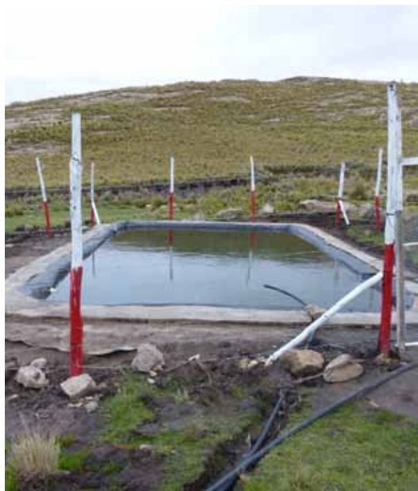
Foto 8: Construcción de un AFRAV en Bolívar.
