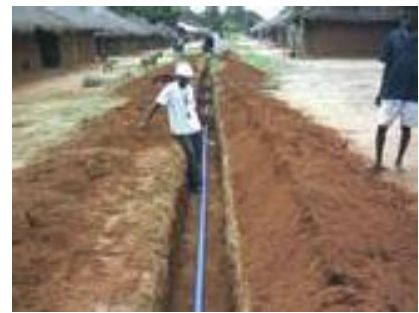
Die neuen Rohre werden verlegt.
