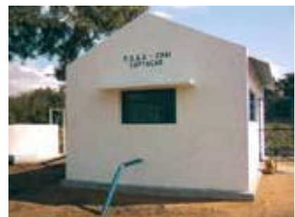
Die Pumpstation von Chai ist fertig gestellt.
