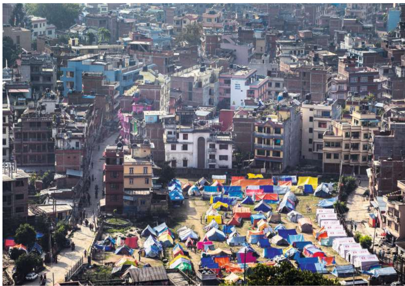
Viele Häuser in Kathmandu sind nicht eingestürzt, aber baufällig. Die Leute wohnen in Zelten.
