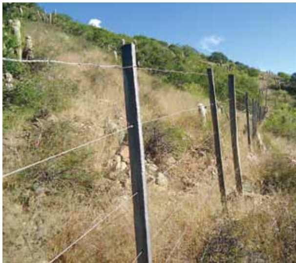
Foto 12: Establecimiento de cerramiento de un área de recarga hídrica en Yunchará.
