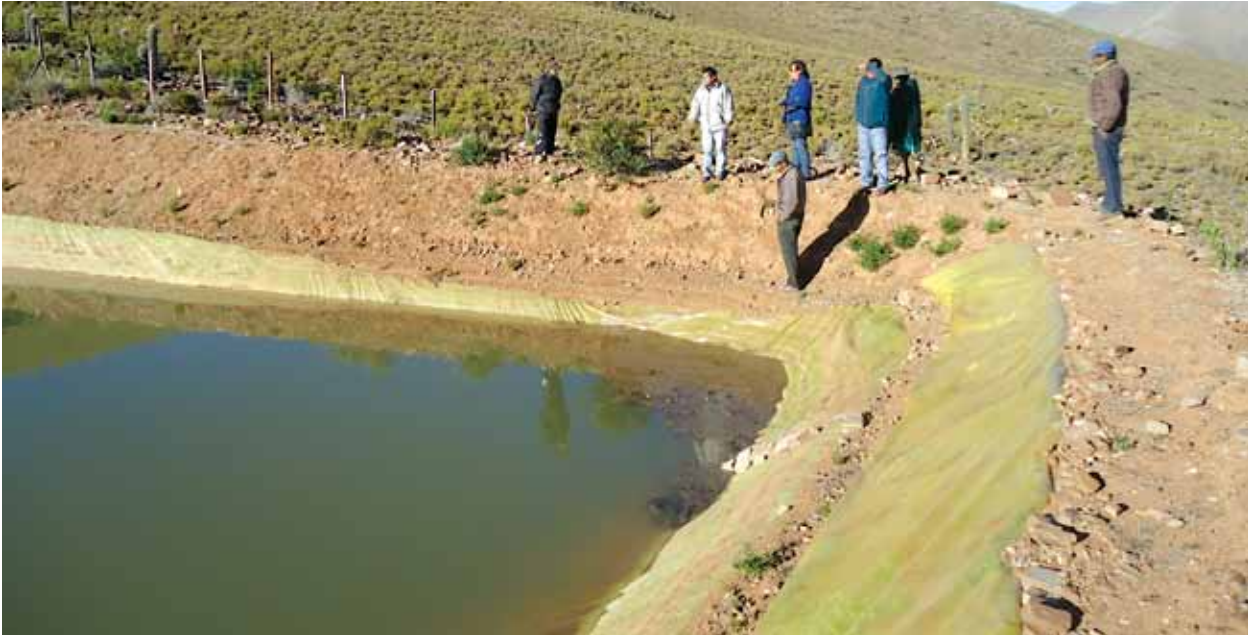
Foto 21: Impermeabilización de atajados en la cuenca. Tajzara, Yunchará.
