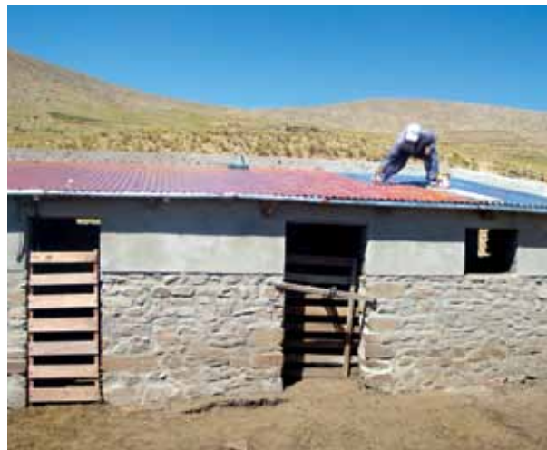
Foto 22: Construcción de un cobertizo para la protección del ganado, Yunchará.
