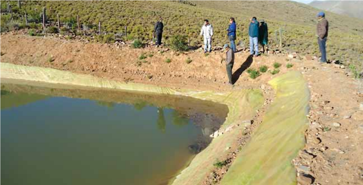
Foto 21: Impermeabilización de atajados en la cuenca. Tajzara, Yunchará.
