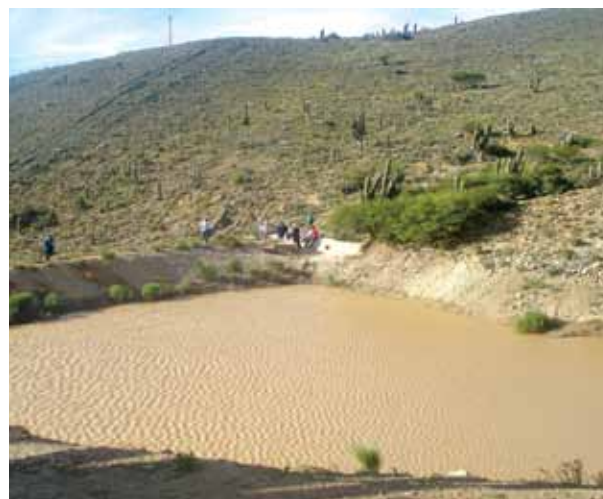
Foto 18: Atajado construido para cosechar agua de lluvias y de las vertientes en El Puente.
