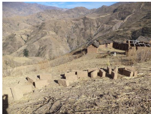
Proceso de fabricación y secado de adobes para la letrina.
